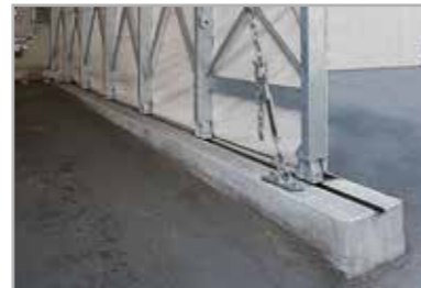
SISTEMA DI ANCORAGGIO PER STRUTTURE RETRATTILI ANCHORING SYSTEM FOR RETRACTABLE STRUCTURES
