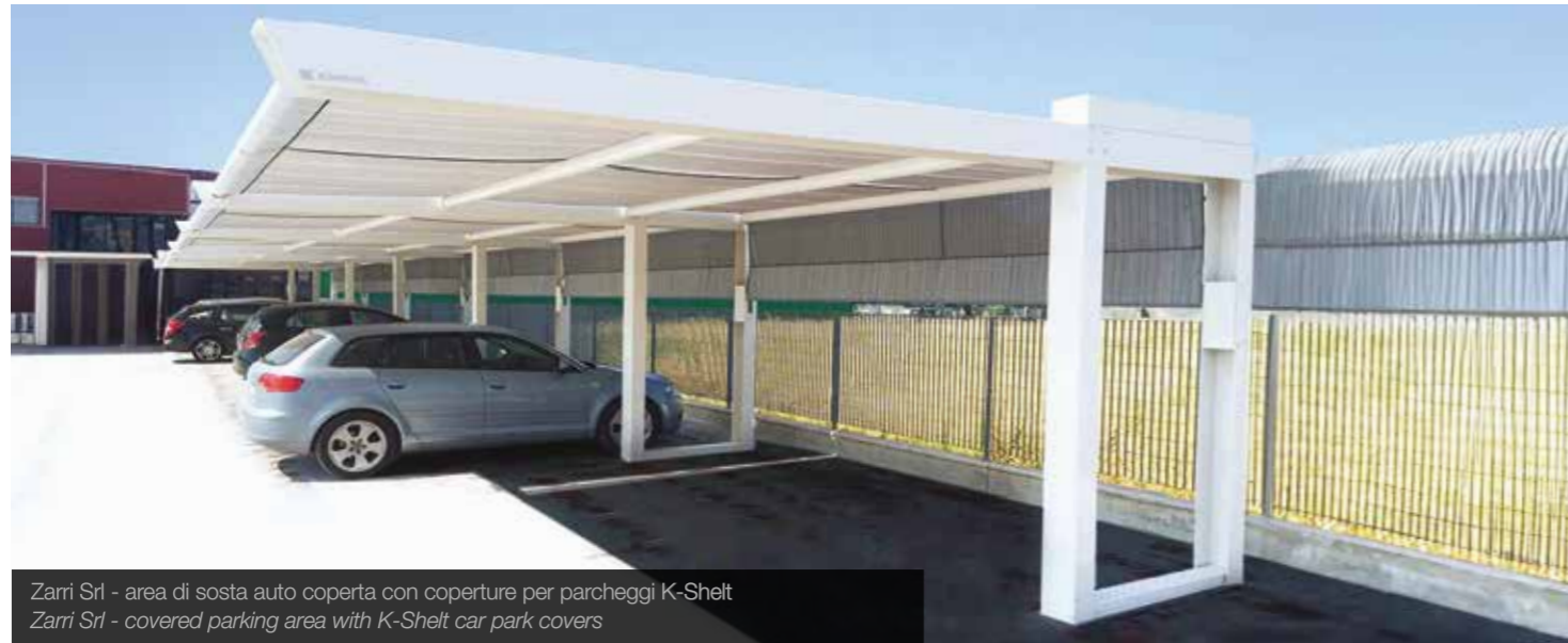
90 pensiline per auto modello K-Shelt all'interno del parcheggio per operatori NCC presso l'Aeroporto L. da Vinci di Fiumicino (Roma) 90 K-Shelt carports in Car Rental with Driver car park in the Leonardo da Vinci airport of Fiumicino (Rome)
