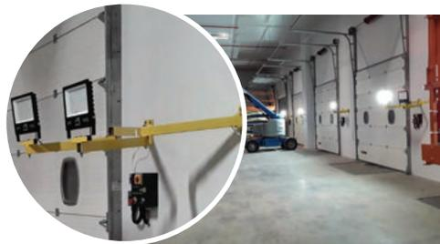
Luminária em LED para doca, com tensão 220V e braço bi-articulado (600+600mm). Possui estrutura pintada em esmalte sintético na cor amarelo segurança, podendo ser fixada na parede com parafusos ou buchas.
