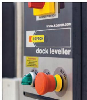
O intertravamento ajuda a evitar acidentes nas docas. O sistema impede que as portas seccionais e niveladoras sejam abertas simultaneamente, ou seja, a porta será acionada somente quando a niveladora estiver totalmente abaixada. Pode ser adquirido isoladamente, desde que haja compatibilidade entre os equipamentos (porta e niveladora).
