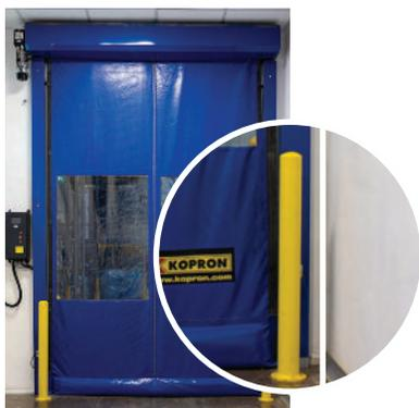
Os bollards são indicados para uso industrial contra colisões em docas, devendo ser instalados em pisos planos. São protetores produzidos em aço reforçado, com grande resistência mecânica e ótima visibilidade, tendo a pintura na cor amarela para atender normas de segurança. Possui alta durabilidade e ótimo desempenho.
