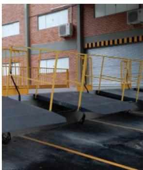
O guarda corpos sobre niveladora é uma estrutura em aço utilizada para aumento da segurança dos indivíduos e dos maquinários em locais com grande movimentação de cargas. Instalado nas laterais da plataforma avançada de doca, é ofertado nas versões fixa ou retrátil, para melhor adequação à demanda e espaçamento do cliente.
